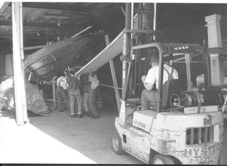
Aanbrengen eerste vlakdeel.
